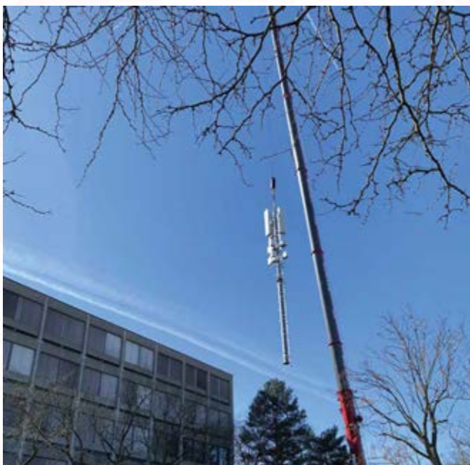
Platzierung des Mobilfunkmasts
