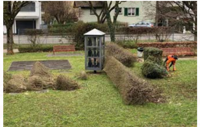
Rodungsarbeiten im Garten
