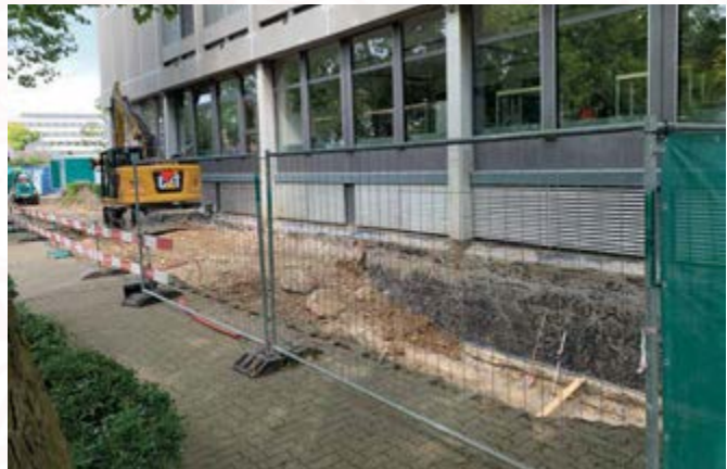
Neue Anlieferungsrampe im Bau
