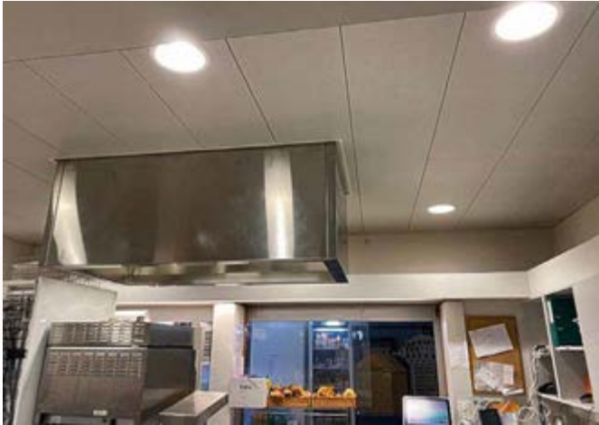
Frisch renovierte Decke beim Kiosk
