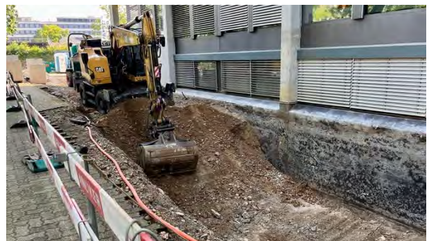
Baggerarbeiten vor dem Schulhaus
